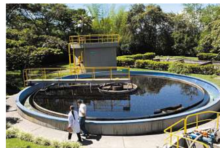
Die Abwasseraufbereitungsanlage unserer Fabrik in Bugalagrande in Kolumbien, eine unserer 292 Anlagen dieser Art weltweit.
