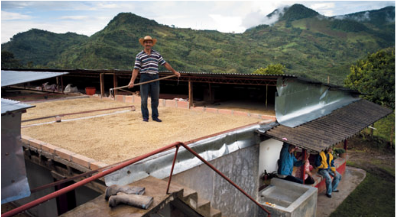
Die Kaffeeverarbeitungsanlage Jardín Antioquia in Kolumbien – eine Initiative von Nespresso, lokalen NGOs und Kaffeekooperativen – ermöglicht Bauern die gemeinsame Nutzung.
